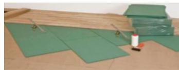
Holzweichfaserplatten für Trockenverlegung Laminat, Parkett, Kork usw. vermindert Trittschallübertragung und verbessert die Wärmedämmung. Bestens geeignet für Elektrofussbodenheizungen
